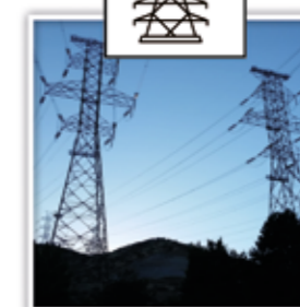
TRANSPORT DISTRIBUTION D'ENERGIE
